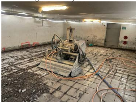
All betong togs bort i skyddsrummen och ny armering lades in
